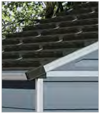
Hliníkový rám a „šindelová“ střecha
